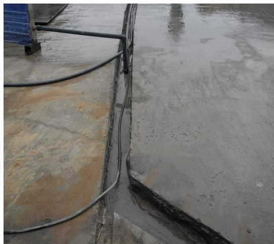
场地临时排水
