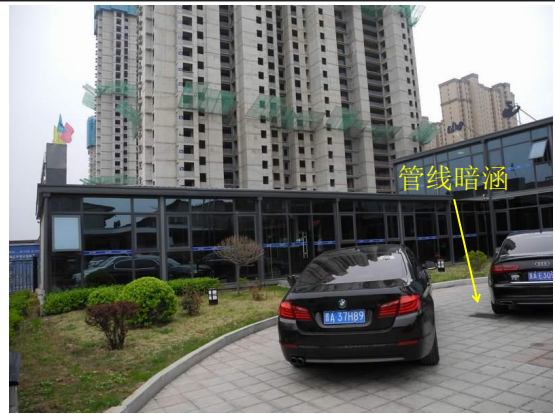
施工生活区临时绿化和排水
