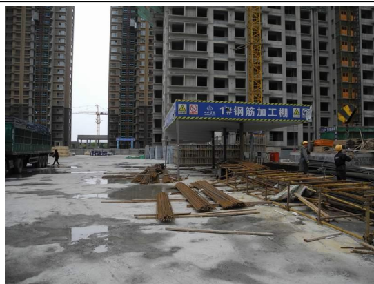
10#楼施工生产区
