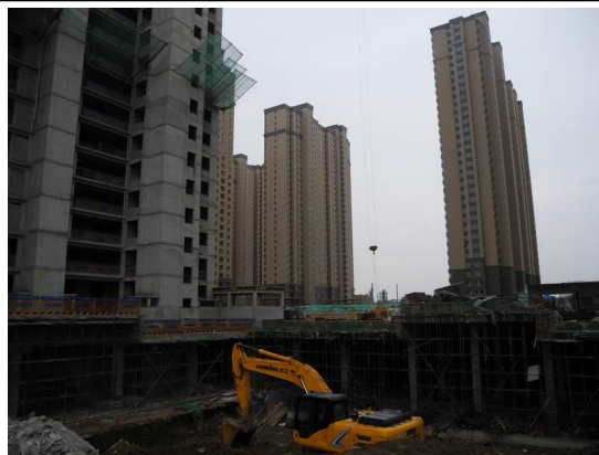
7#楼附近地库开挖
