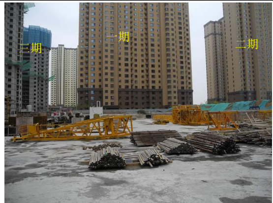
材料临时堆场（占用公共绿地）
